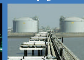
LNG Terminal Project Petronet LNG Ltd.
